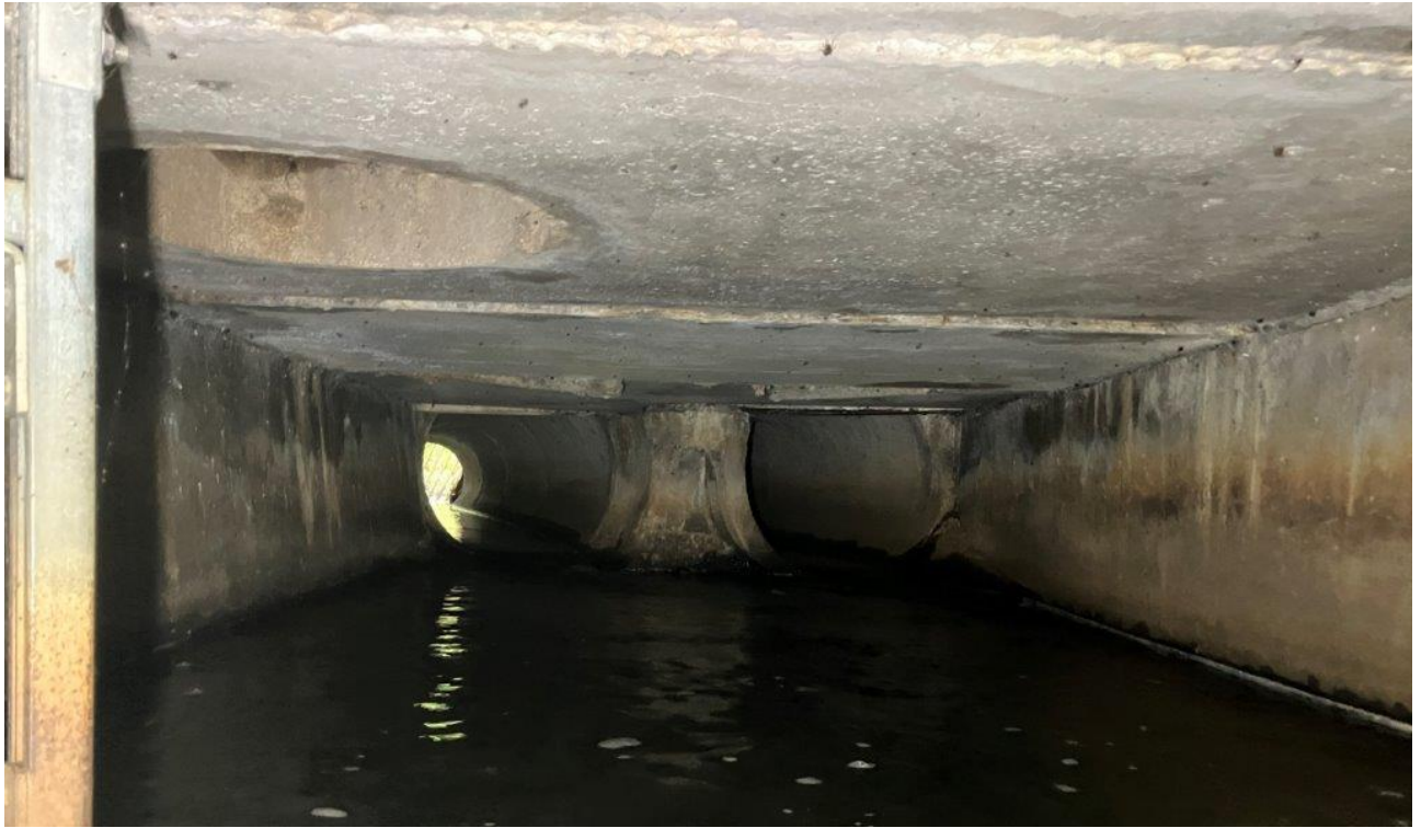
Abb. 3: Stahlbeton-Brückenbauwerk, im Hintergrund Doppel-Verrohrung, Blickrichtung: Norden
