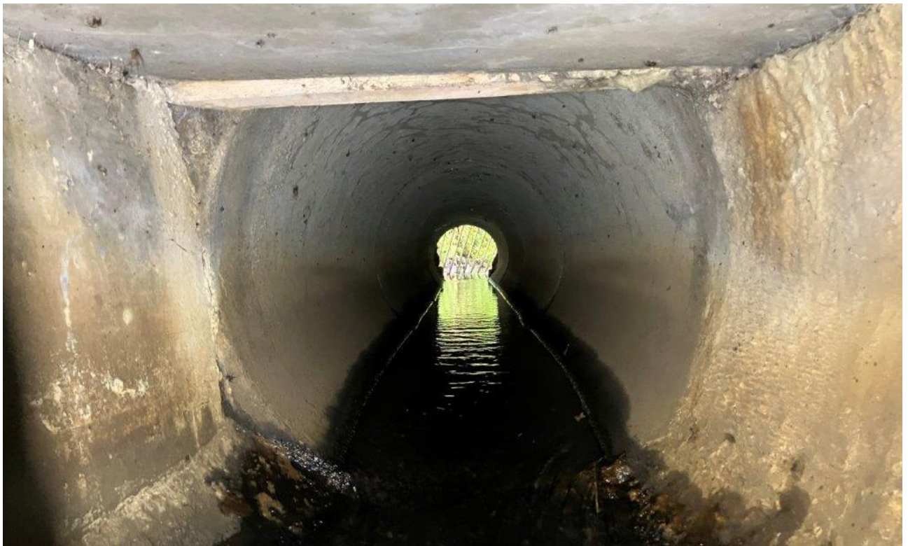
Abb. 4: Stahlbeton-Brückenbauwerk, Blick in westliche Verrohrung, Blickrichtung: Norden
