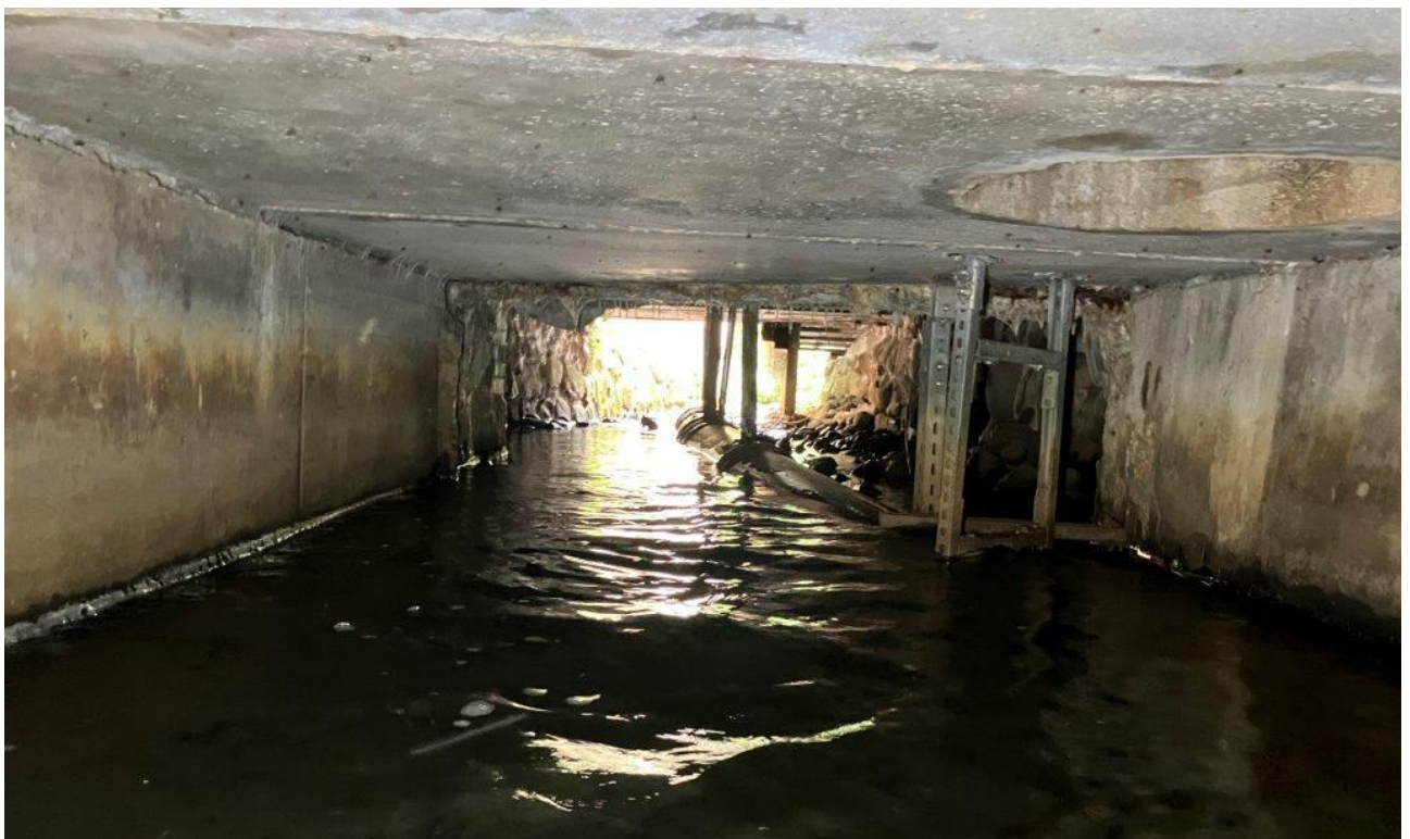
Abb. 6: Stahlbeton-Brückenbauwerk, im Hintergrund Holdeckkonstruktion, Blickrichtung: Süden
