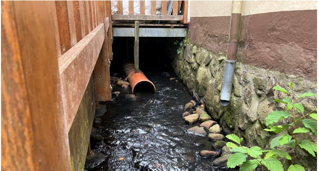
Abb. 1: südlicher Auslass mit Holzsteganlage und RW-Übergabebauwerk, Blickrichtung: Norden
