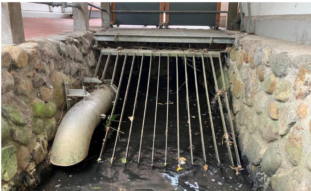
Abb. 7: Einlassbauwerk nördlich der Doppelverrohrung mit Stahlrechen, Blickrichtung: Süden
