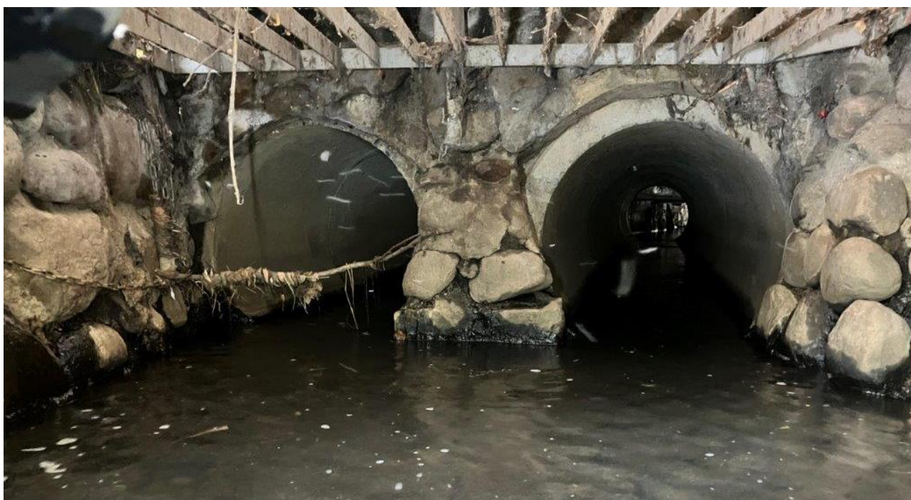
Abb. 8: nördliches Bauwerkende Doppel-Verrohrung, Blickrichtung: Süden
