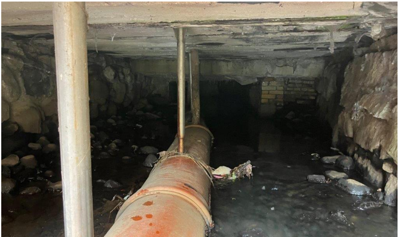
Abb. 2: Bereich unterhalb Holzdeckkonstruktion (Rückbau geplant) mit RW-Übergabebauwerk, im Hintergrund Übergang zu Stahlbeton-Brückenbauwerk, Blickrichtung: Norden
