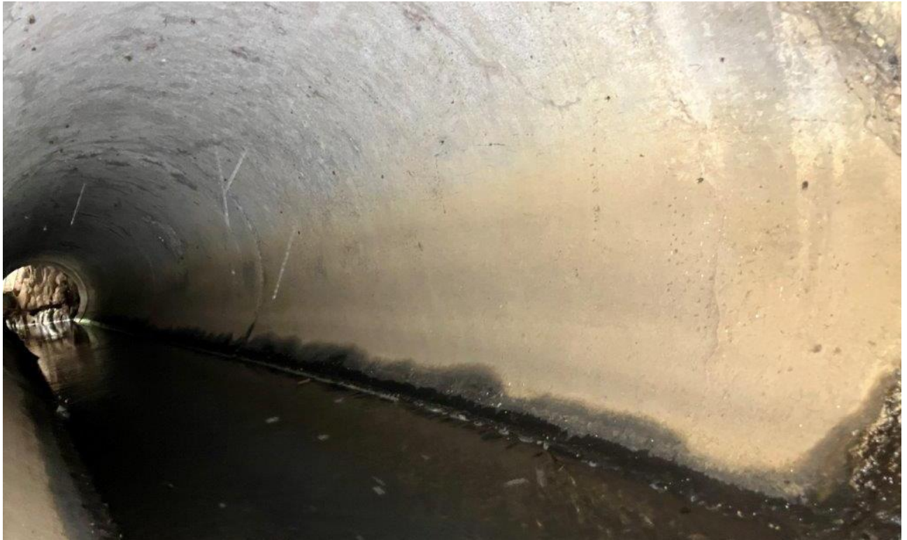
Abb. 5: Stahlbeton-Brückenbauwerk, Blick in östliche Verrohrung, Blickrichtung: Norden
